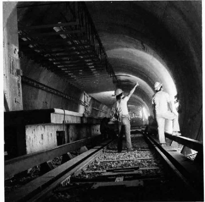
Detalle de las obras en túnel en la estación Viveros; abajo, nave de depósito de trenes, ubicada al sur de la estación Ciudad Universitaria.
