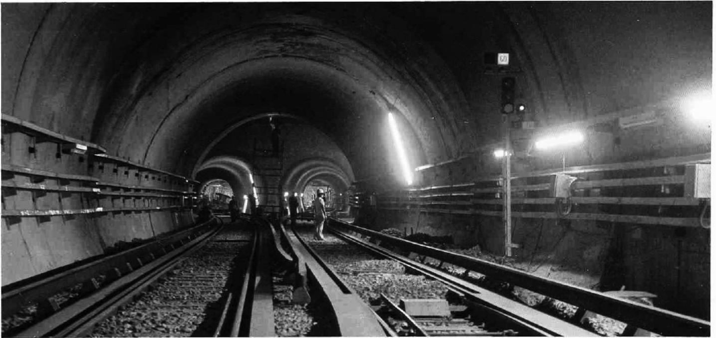
Vista del túnel en la "zona de pantalón", entre las estaciones Miguel Angel de Quevedo y Copilco.
